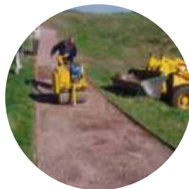
COMPACTAR A NIVEL DE SUPERFICIE
